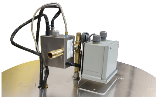
Photo 25 : Raccordement de l'embout de 3/4 po x 3 po à la vanne Platinum
