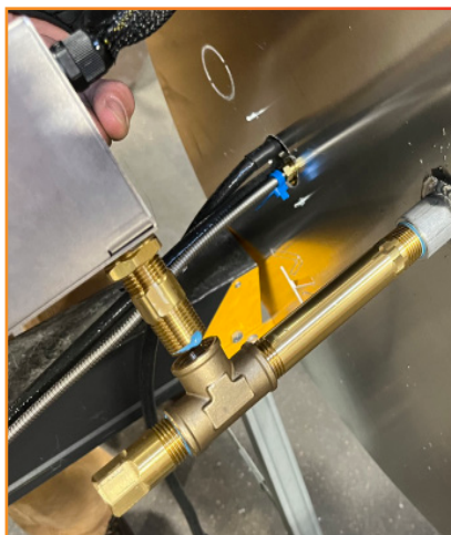
Photo 9 : Fixation du boîtier de soupape à la jambe d'égouttage
