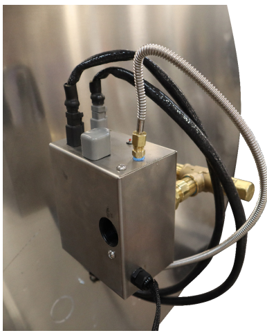
Photo 12 : Raccordement de la conduite de gaz du pilote à la vanne
