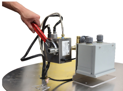
foto 20: Conexión del accesorio abocinado a la válvula de platino
